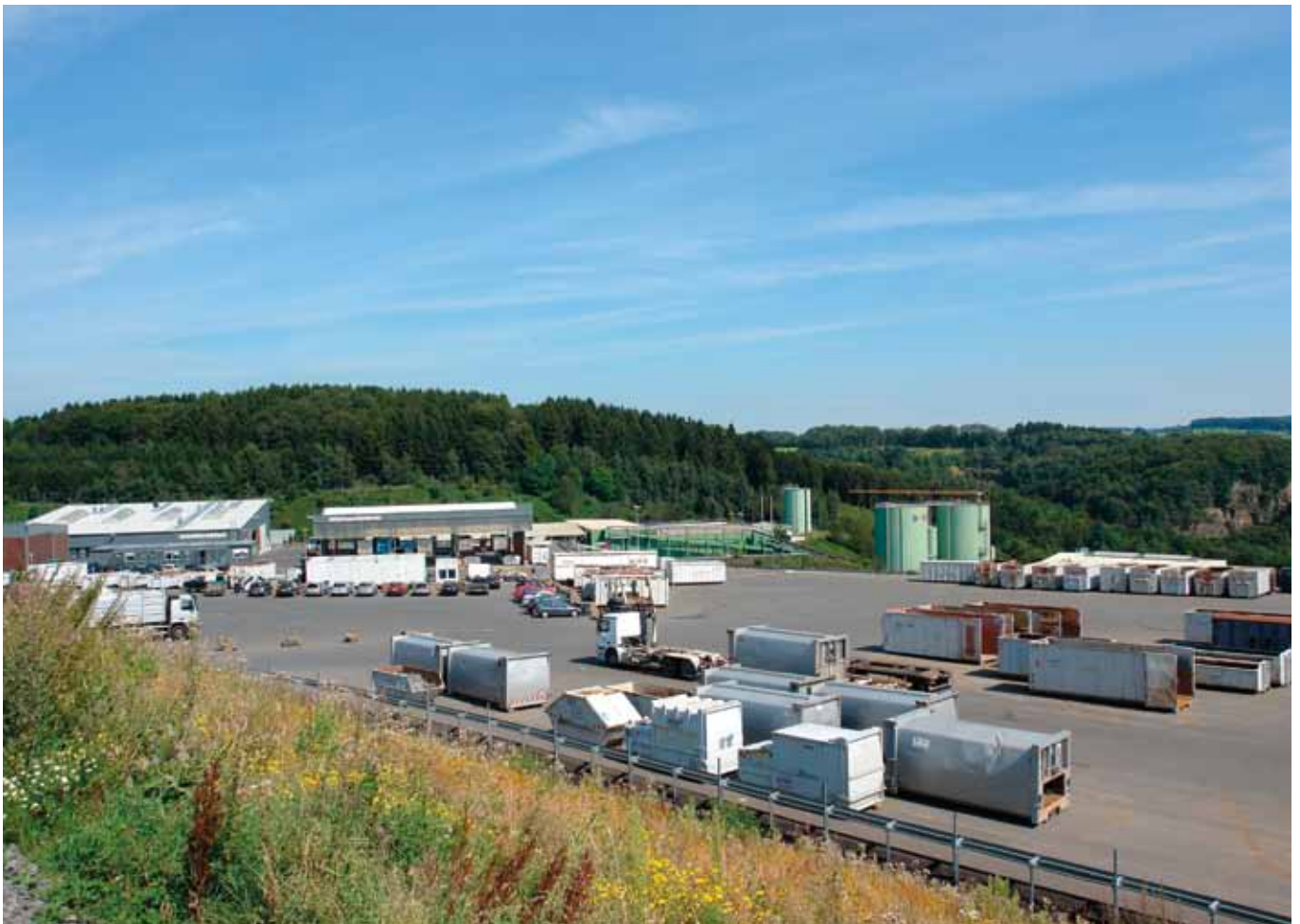
Nachhaltiges Gewerbegebiet der Deponie Leppe
