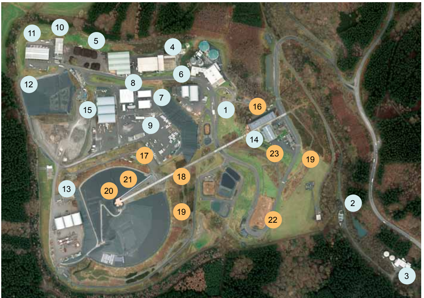
Luftbild des Entsorgungszentrums Leppe
