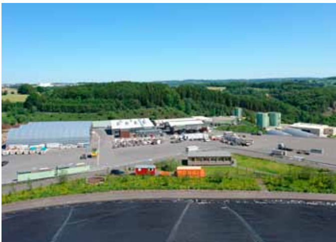
Nachhaltiges Gewerbegebiet der Deponie Leppe
