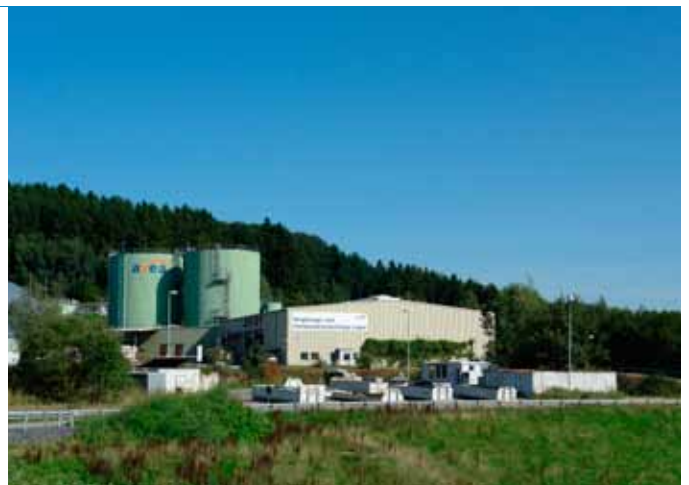
Vergärungs- und Kompostierungsanlage Leppe
