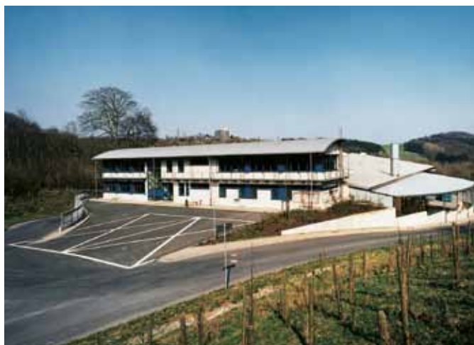
Sortieranlage Bockenberg in Bergisch Gladbach
