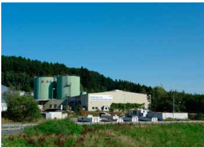
Vergärungs- und Kompostierungsanlage Leppe
