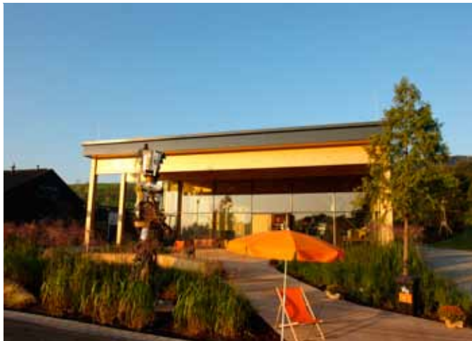
Bergisches Energiekompetenzzentrum - Aussenansicht
