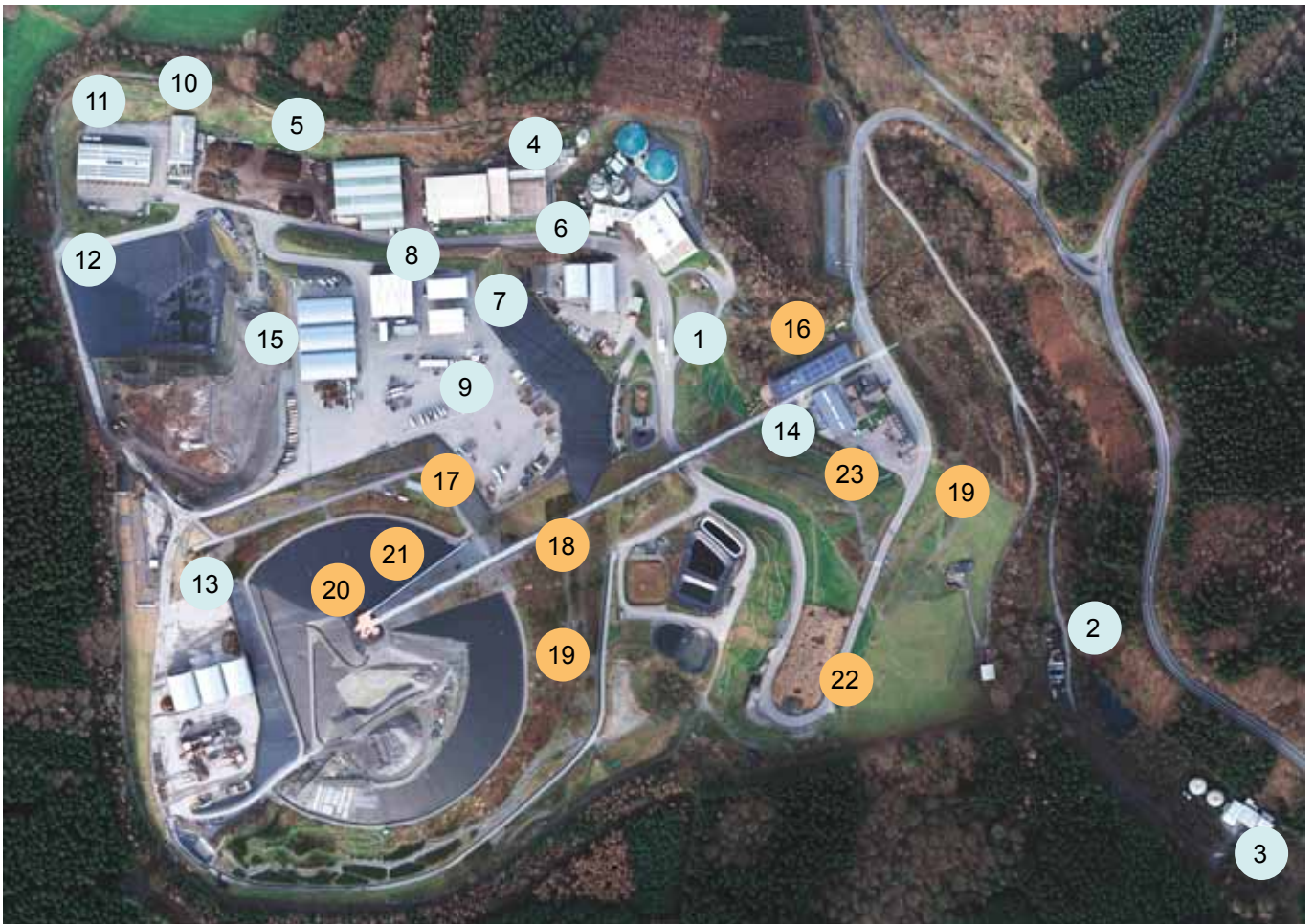
Luftbild des Entsorgungszentrums Leppe
