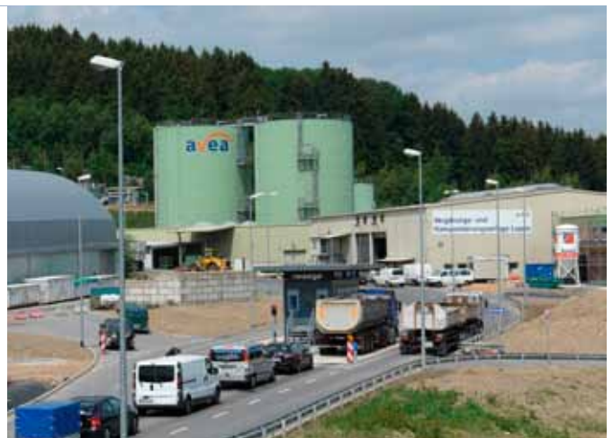
Vergärungs- und Kompostierungsanlage
