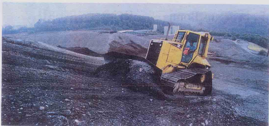
„Bergbau“ im Bergischen Land: Auf der früheren Leppdeponie in Lindlar werden Rasen mit Rastasche aus der Leverkusener Müllverbrennungsanlage den um Ende 350 Meter hohen Kegel für das „Metabolon“-Projekt der Regionale 2010.
